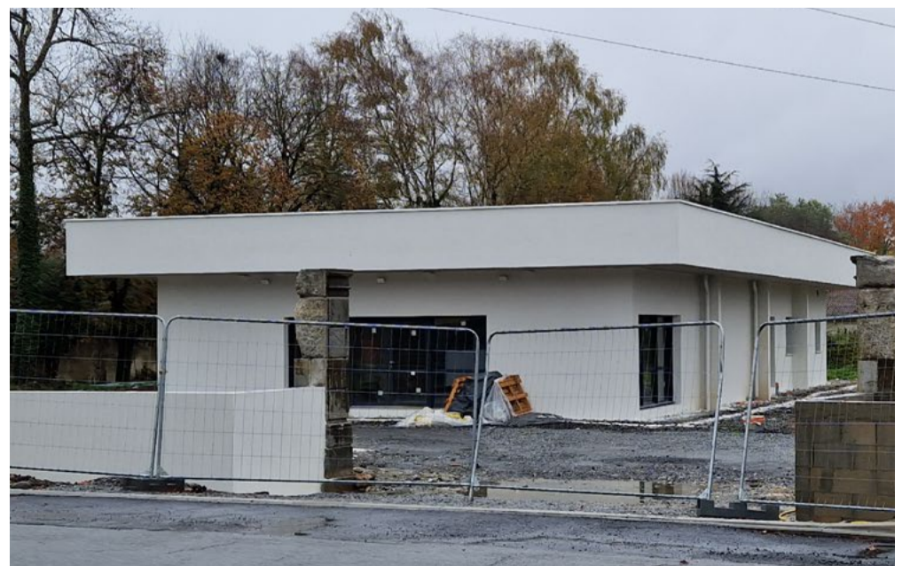
Construction du laboratoire d'analyses médicales
