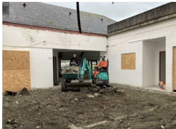
Le patio pendant la démolition
