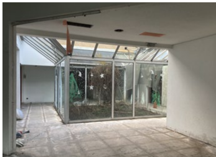
Le patio avant la démolition
