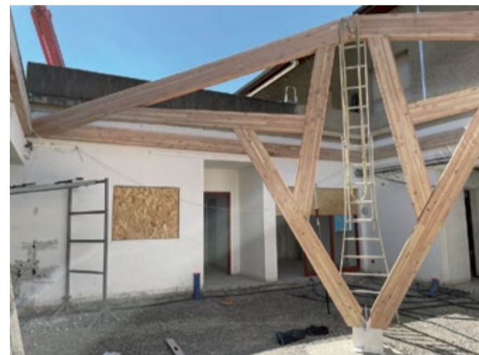
Pose de la nouvelle charpente
