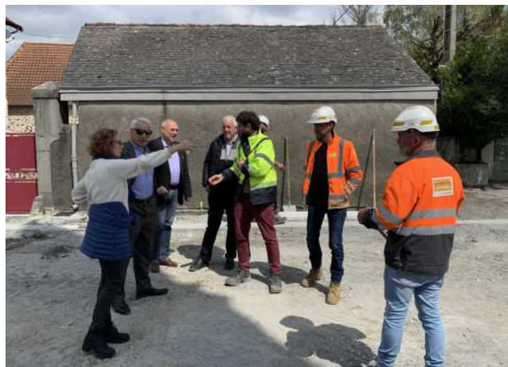
Un point d'étape à mi-chantier a été effectué sur la pacification de la RD37.
