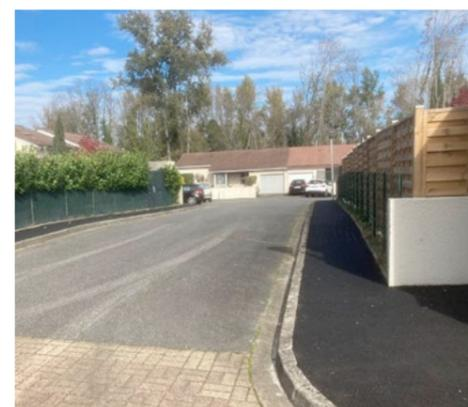
→ Des travaux de voirie ont été réalisés fin septembre sur la Rue du Fer à Cheval afin d'améliorer la sécurité et le confort des riverains et des usagers : aménagement d'un ralentisseur, réfection de tous les trottoirs en enrobé, rénovation de la chaussée au niveau de la petite placette privée située à l'entrée du lotissement.
