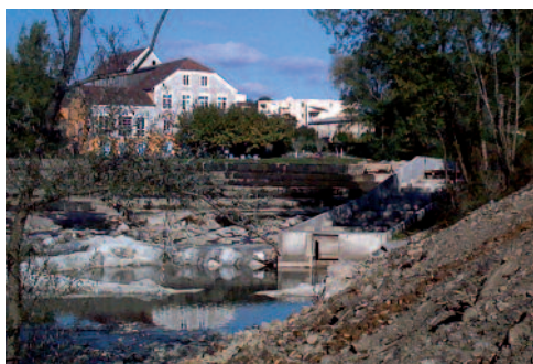
La passe à poissons en chantier
