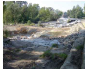
Construction d'une « échelle à poissons ».
