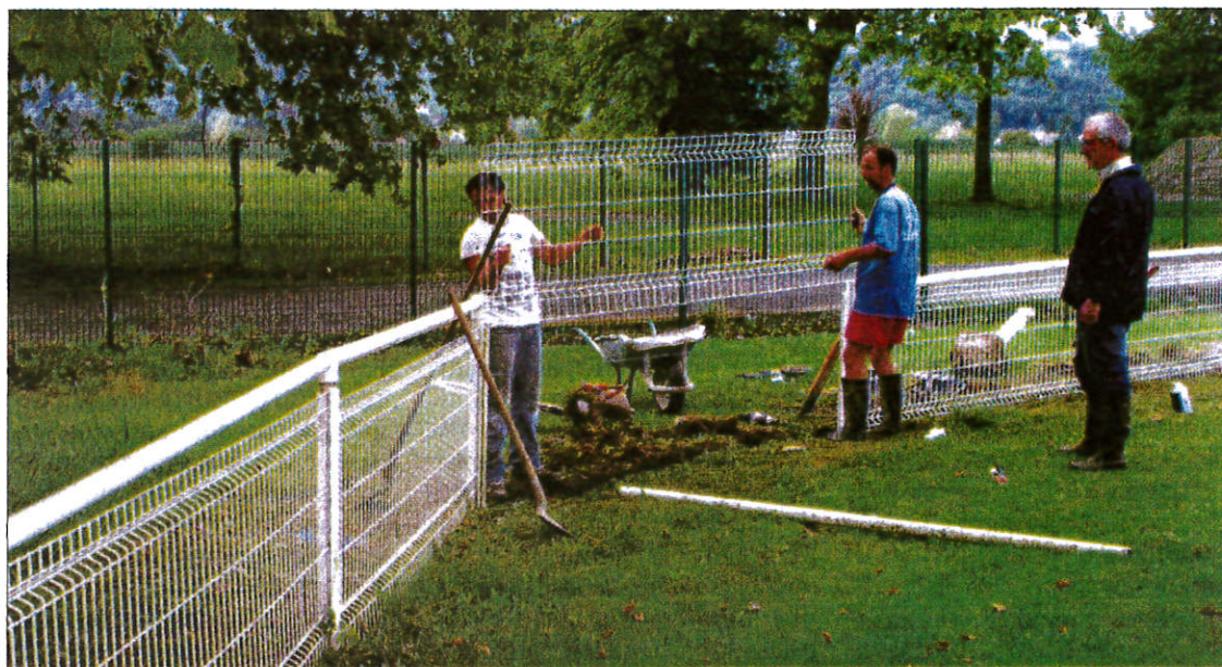
Sous l'œil attentif de Roger Pédeflous (adjoint au maire), les techniciens de l'entreprise Lacave ont changé divers éléments de la main courante. PHOTO D. J.-H.
