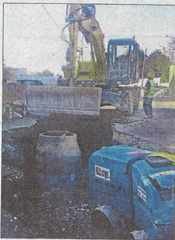
Les travaux d'aménagement doivent s'achever fin janvier 2013. PHOTO DR
