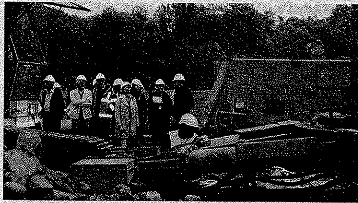
Pendant le forage, élus et techniciens rassemblés devant le louvoyeur de 15 tonnes. ©PP
