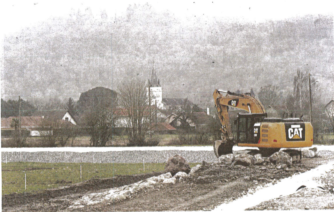
La digue en cours de construction serpente à travers champs sur plus de 700 mètres pour protéger le quartier de Mazères-Lezons le plus proche du gave de Pau... et de la rocade
