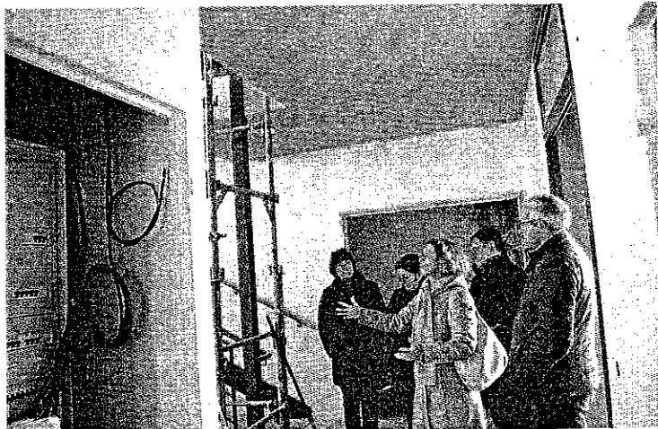
Monique Sémavoine, le maire, et les représentants de la municipalité ont visité le chantier. PHOTO D. J.-H.
