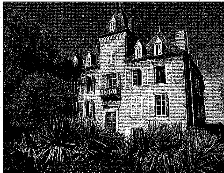
Dans les murs du château, a été installé l'institut médical éducatif.
