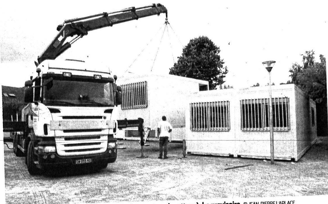
14 modules du type « Cougnaud » forment la structure de cette crèche provisoire. © JEAN-PIERRE LAPLACE
