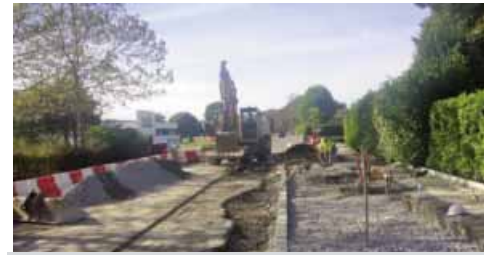
Aménagement d'un «quai-bus» devant le Sulky
